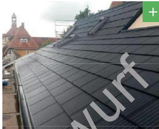
Abbildung 45: Unauffällige, hochwertige Solarziegel.
