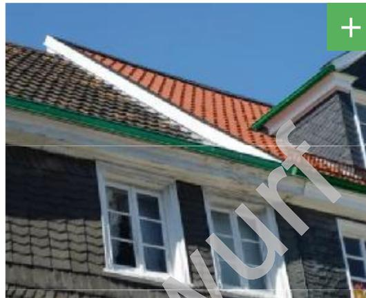
Abbildung 24: Beispiel für eine gelungene Aufdachdämmung (Farben hier nicht angepasst).
