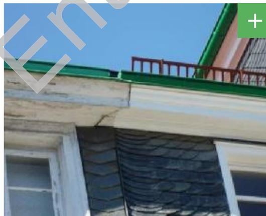
Abbildung 25: Durchlaufender Traufkasten bei zwei Gebäuden.
