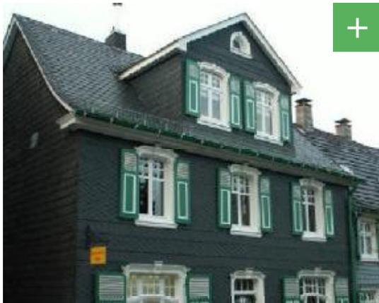
Abbildung 30: Dach mit Schieferdeckung.
