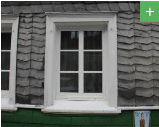
Abbildung 67: Pfostensprossenfenster als Gestaltungselement der Fassade.
