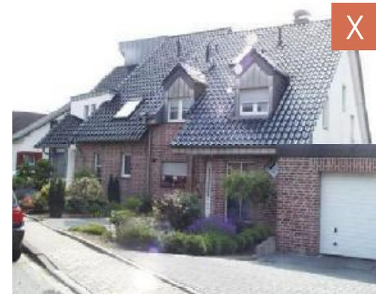
Abbildung 34: Störende Reflexionen durch glasierte Dacheindeckung.
