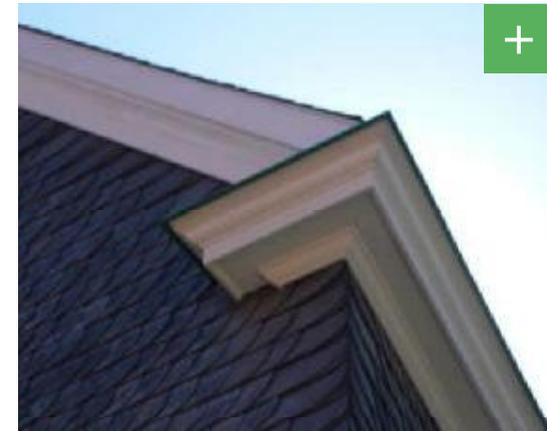
Abbildung 26: Unauffällige Aufdachdämmung unter Berücksichtigung der Gesimse.
