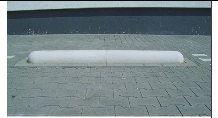
Anfahrsschwelle 20 x 15 x 180 in Überhangstreifen mittig vom Parkstand
